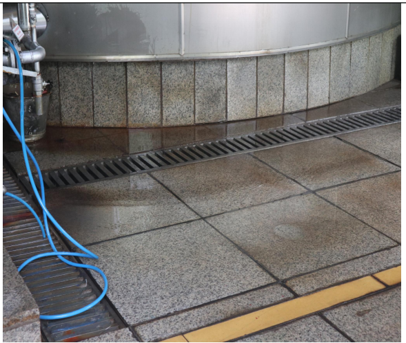
水相制备工房水相储罐旁应急沟
