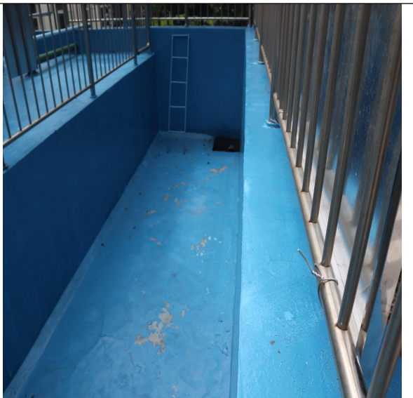
硝酸铵溶液储罐围堰内应急池
