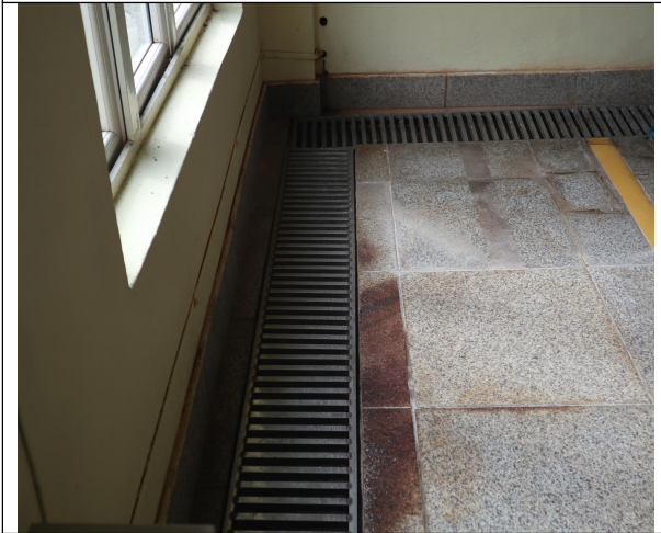
生产车间内应急地沟
