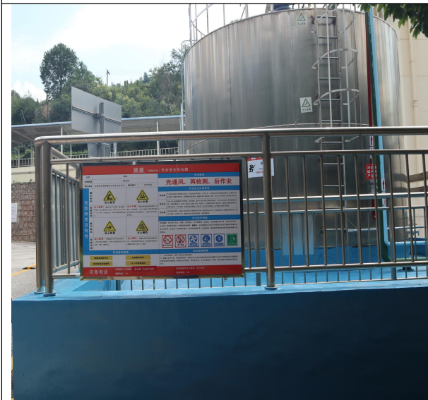
硝酸铵溶液储罐围堰
