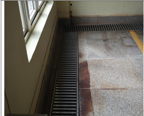
生产车间内应急地沟
