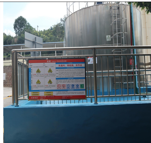
硝酸铵溶液储罐围堰
