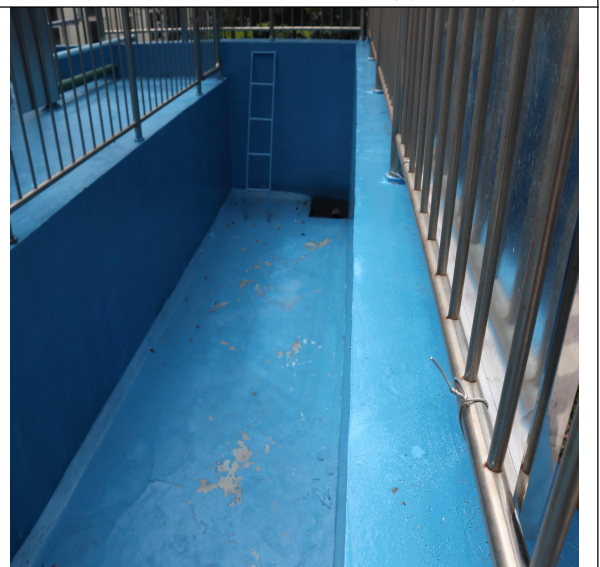
硝酸铵溶液储罐围堰内应急池
