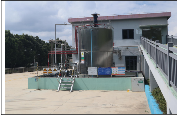
硝酸铵溶液储罐围堰
