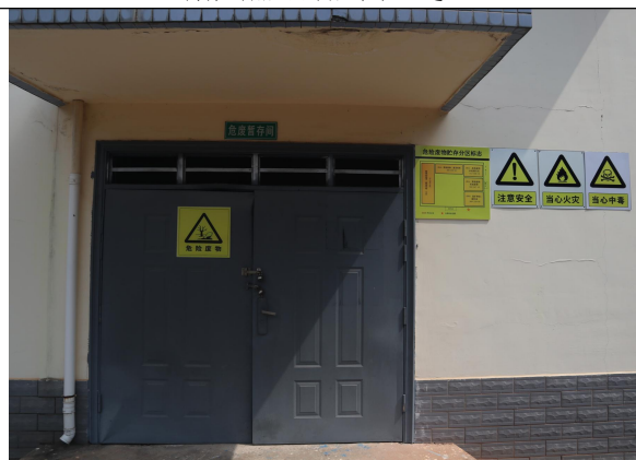
危险废物暂存间
