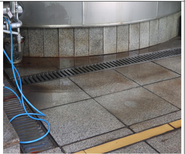
水相制备工房水相储罐旁应急沟
