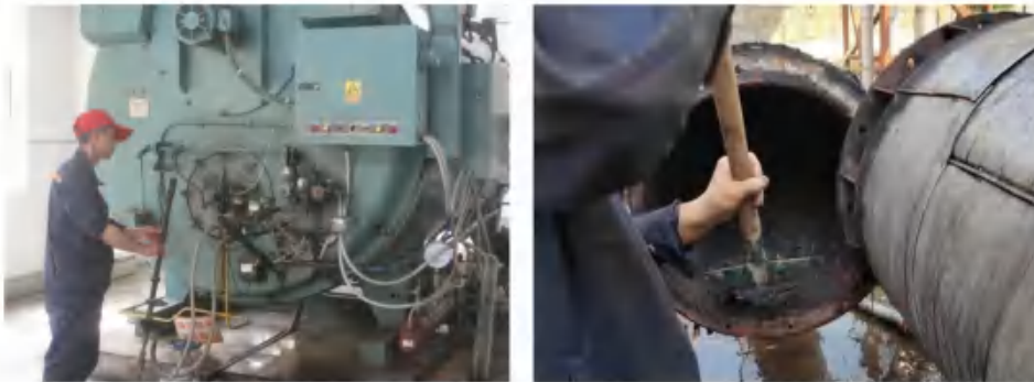
图 3：锅炉检修作业
