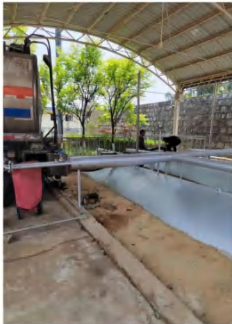
图 5：储油罐、燃油输送管道清洗
