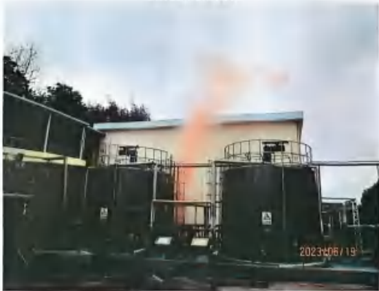
液氨罐罐区发生事故
