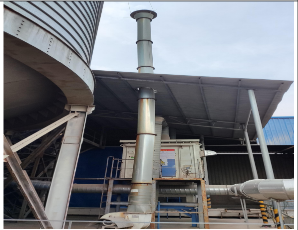
初清理废气布袋除尘器及排气筒
